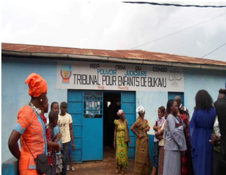
Image 7 : Tribunal pour enfants de Bukavu abrité dans le bâtiment de la Commune de Kadutu. Notre photo, le 16 avril 2015.
