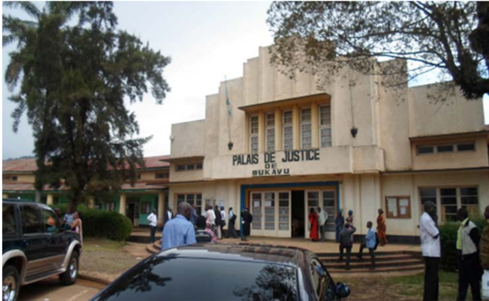
Image 2 : Palais de Justice de Bukavu après sa réhabilitation par le projet REJUSCO. Notre Photo, 16 avril 2015.
